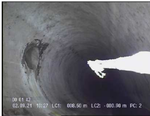
Foto 002 Videopáska: 110 Stav S--O 8,50 m 10 - 11 hod. Zaústění, V horní části
