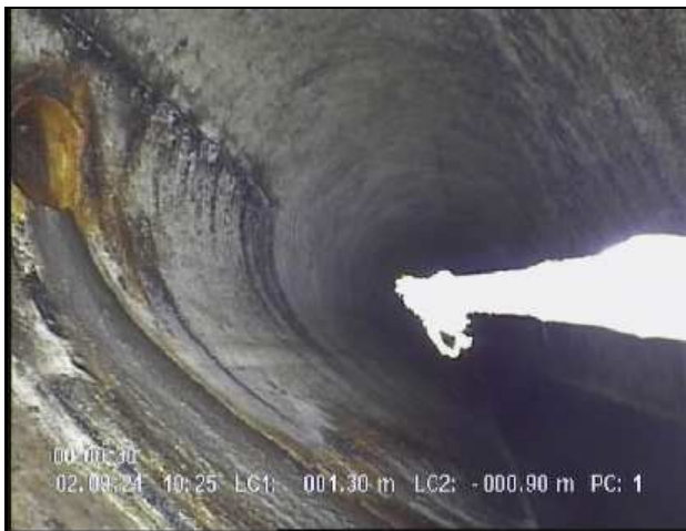
Foto 001 Videopáska: 110 Stav S--O 1,30 m 10 - 11 hod. Zaústění, V horní části
